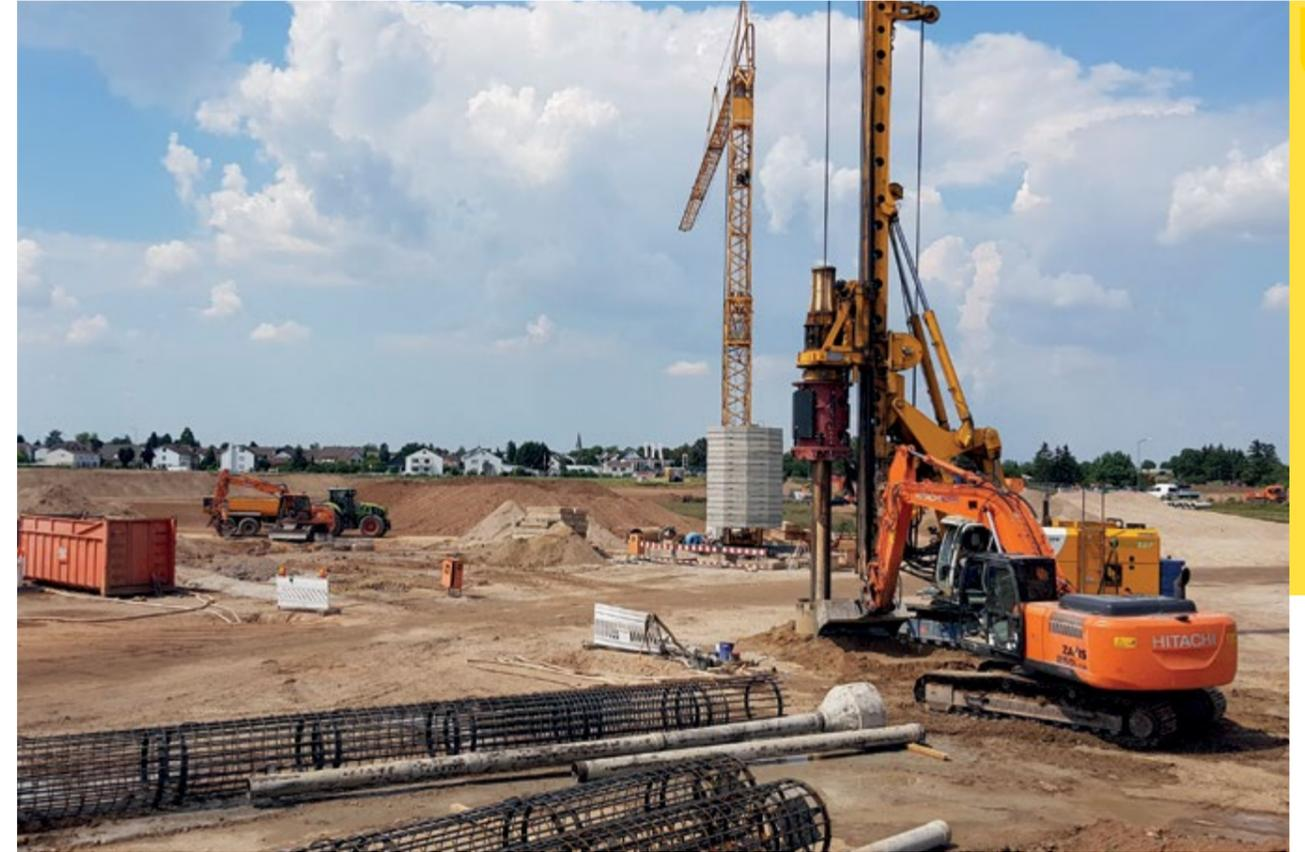
Die Brücke über die neue B 47n Südumgehung Worms wurde auf Bohrpfählen gegründet. Die Spezialtiefbauer waren im Sommer mit großem Bohrgerät vor Ort und haben die 14 Meter langen Ortbetonpfähle hergestellt.
