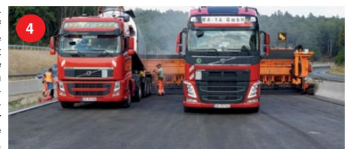
Abdichtung von hochbelasteten Straßenoberflächen, Brückenbauwerken, Parkdecks, Tiefgaragen und Gebäuden eignet. Gussasphalt ist aber auch als Bodenbelag in Gebäuden immer stärker im Kommen. Der Baustoff zeichnet sich durch hohe Dichte, Elastizität und Griffigkeit aus.
