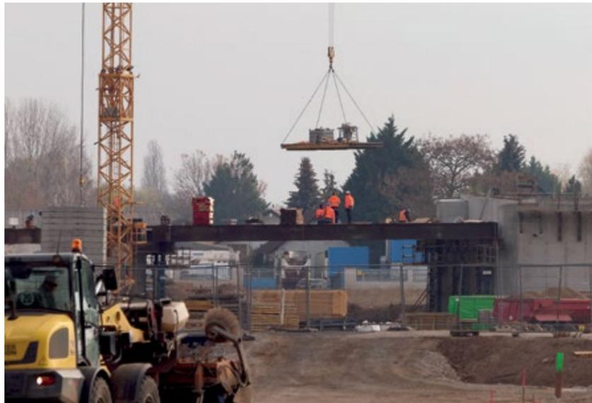
Das Traggerüst wird für die Schalung vorbereitet: Ende Januar erfolgte bereits die Betonage des Überbaus.
