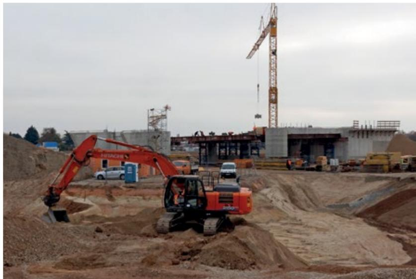
Rechts und links neben der Brücke werden die Fahrbahndämme aufgeschüttet, davor wird ein großes Versickerungsbecken angelegt: Das Oberflächenwasser soll vor Ort versickern.
