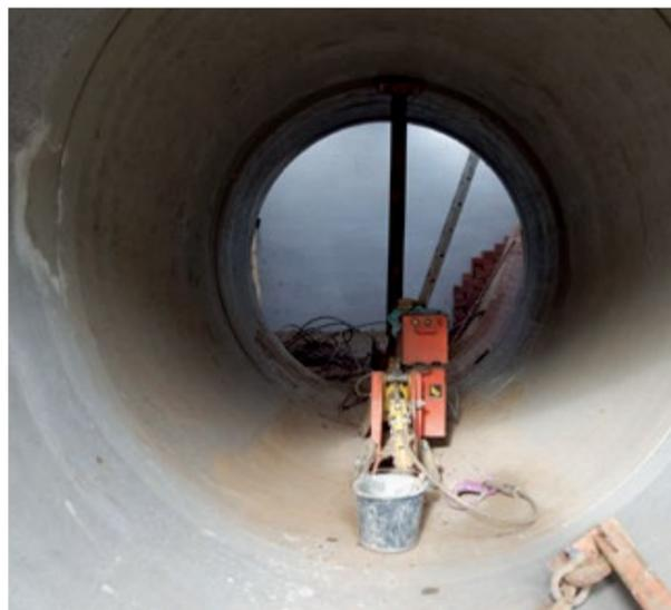
Kein Problem, den Stauraumkanal zu durchschreiten. Die Betonelemente wurden mit einem hydraulischen Seilzug zusammengezogen. Die Drosselbauwerke werden mit Ziegeln ausgeklüffert.
