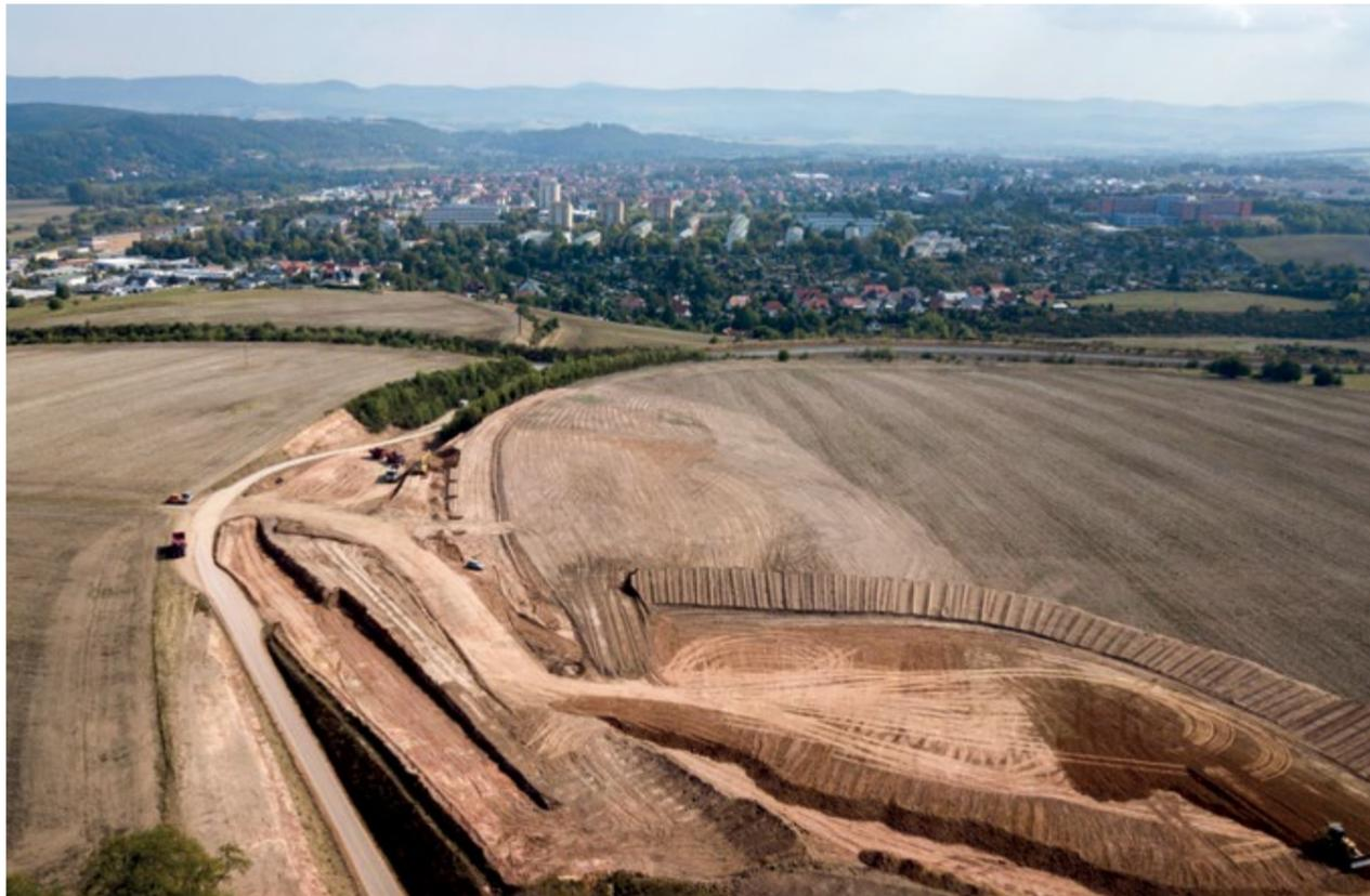
Großer Erdbau vor den Toren Bad Salzungen: Der 4. Bauabschnitt der B 62 Ortsumgehung schließt an das südwestliche Ende der bestehenden Umgehung an. Unser Drohnfoto zeigt den Blick in Richtung Ost mit dem Bau des größten Regenrückhaltebeckens vorne.
