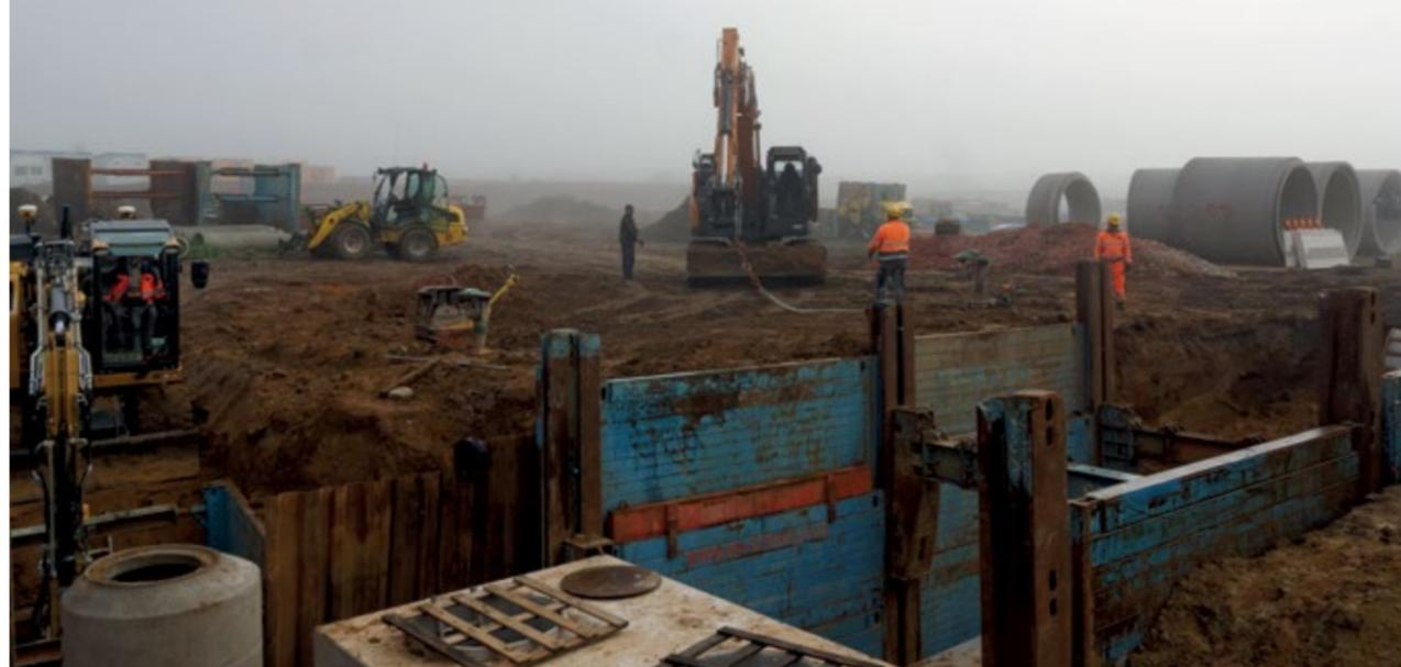
Der Herbstnebel begleitete die Mitarbeiter der Niederlassung Fulda, als sie den großen Stauraumkanal verlegten. Abschnittsweise wurde der Verbau in die Tiefe gelassen, um die Betonfertigteile mit einem Durchmesser von DN 2.400 verlegen zu können.
