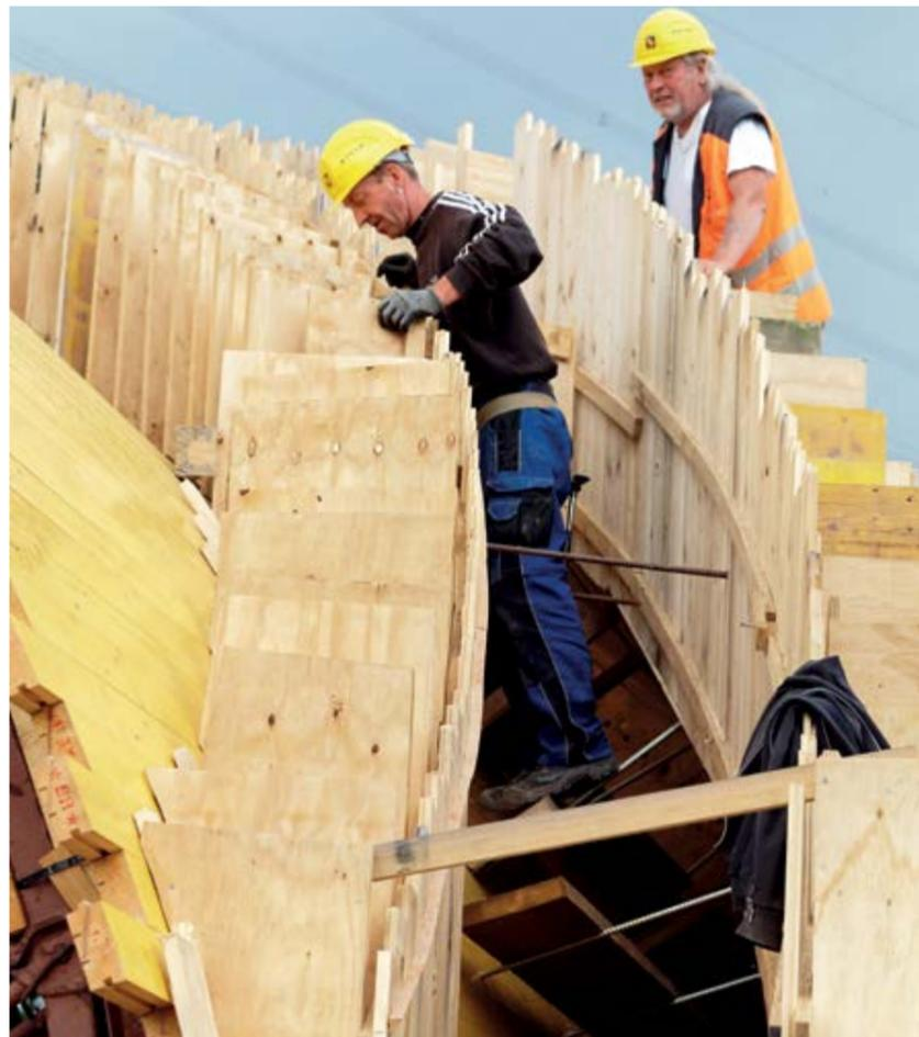
Für die Rundbogenunterführung Bauwerk 4 müssen die Brückenbauer eine aufwändige Schalung herstellen.
