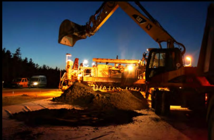
*Dauereinsatz für die Betonstraßenbauer: Ihre Fertiger waren rund um die Uhr im Einsatz. Für einen ununterbrochenen Materialzufluss sorgten zwei Mischanlagen – eine für Beton und eine für Asphalt (Foto links) – die am Trassenbereich aufgestellt wurden.*
