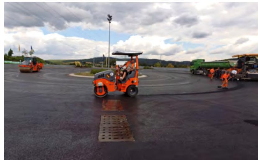
*Asphalteinbau mit Hindernissen: In der Kreisbahn-Oberfläche sind zahlreiche Einbauten und Sprinkler eingelassen.*
