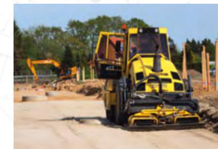
Auf Sand gebaut: Um den Boden zu verdichten, wurden in Stade Trengleplatten eingesetzt.
