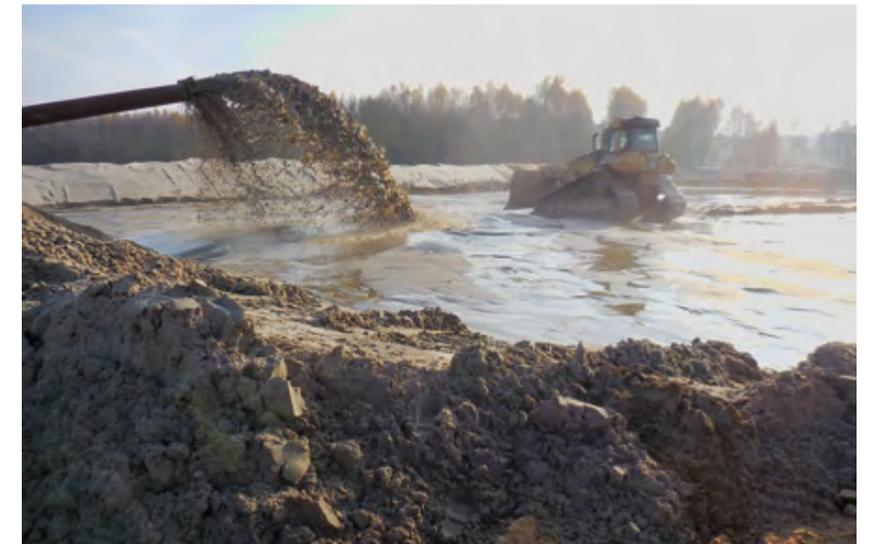
Matsch marsch!: Durch Pipelines wurde ein Wasser-Sand-Gemisch in ein Spülfeld gepumpt. Dort setzte sich der Sand ab, das Wasser wurde zurück gepumpt. Mit einem schwimmenden Saugbagger (kl. Foto links) wurde der Sand am Boden des Sees eingesaugt.
